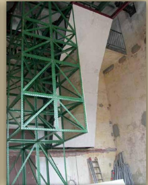
2003: Wandelemente - Wände 5, 6 und 7 hängen an der oberen Haltekonstruktion
