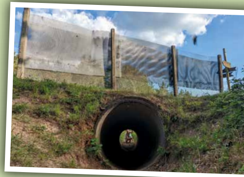
Kilometer 632: Agentenschleuse Wendehausen. Das für den oftmals wasserlosen Graben viel zu überdimensionierte Abflussrohr sollte Agenten der DDR den geheimen Grenzübertritt ermöglichen
